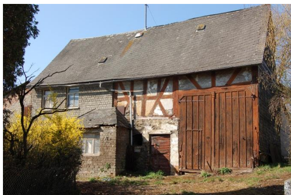
Abbildung 59: Leerstehendes ehemaliges Wirtschafts- und Wohngebäude in Ulm
