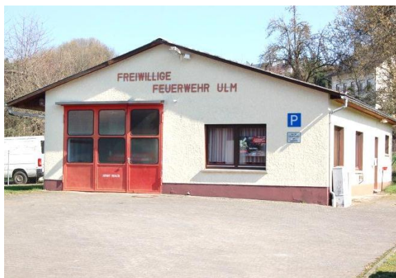
Abbildung 54: Feuerwehrraum in Ulm Quelle: Eigene Aufnahme
