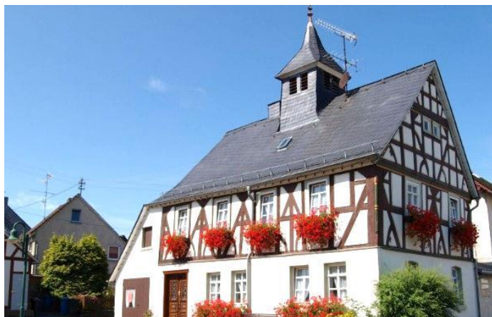
Abbildung 84: Sanierung der Alten Schule in Arborn im Rahmen der Dorferneuerung
