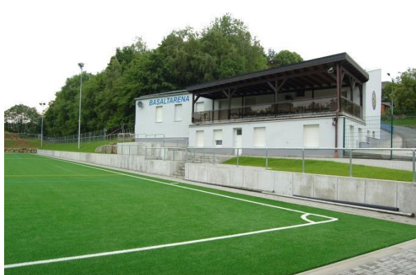
Abbildung 51: Vereinshaus des TuSpo „Nassau“ Beilstein Quelle: Eigene Aufnahme
