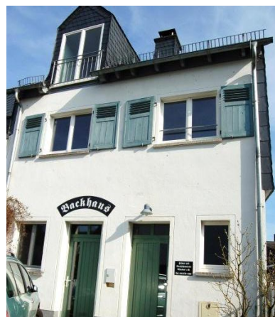
Abbildung 85: Sanierung des Backhauses in Allendorf mit Mitteln des DE-Programms
