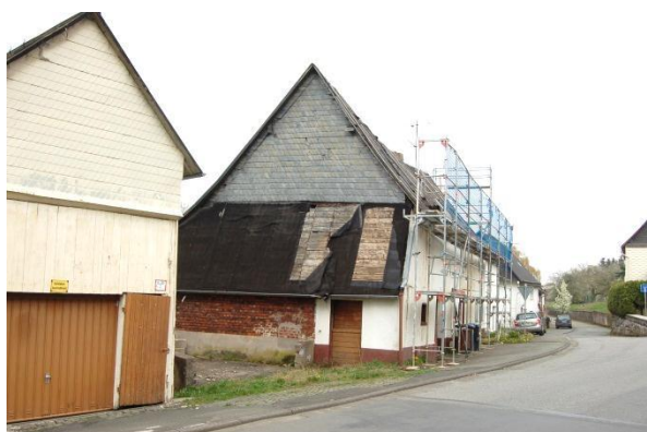
Abbildung 61: Sanierungsbedürftiges Anwesen in Beilstein
