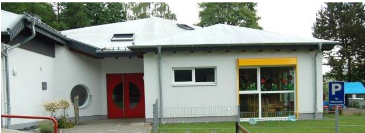
Abbildung 50: Kindergarten in Beilstein Quelle: Eigene Aufnahme
