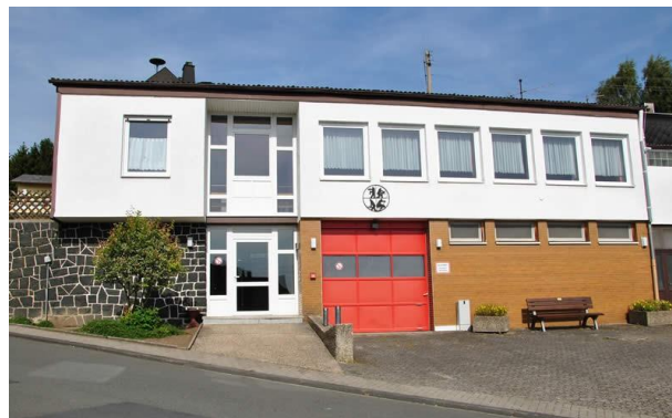
DGH mit Feuerwahrgerätehaus in Rodenberg
