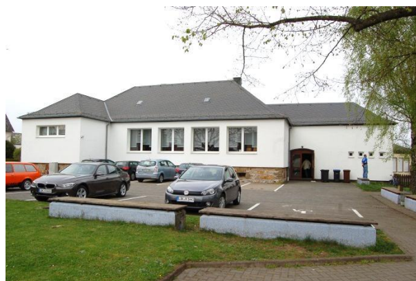
Blick auf das DGH (Quelle: Eigene Aufnahme)
