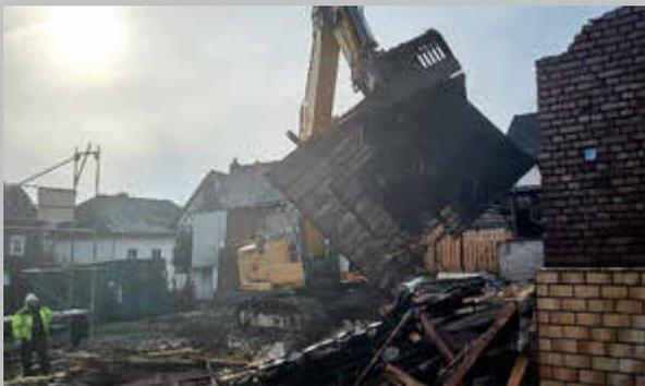
Das Abbruchmaterial muss zwischendurch immer wieder sortiert und abgefahren werden.
