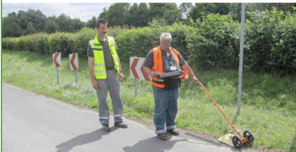
Überprüfen das Gasnetz der EAM: Werner Kapell (re.) läuft den Leitungsverlauf mit dem Gasspürgerät ab, während Bernd Winkelbach den Verkehr im Blick behält.
