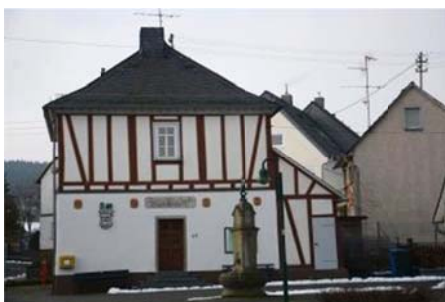
Typisches Beispiel für Sparfachwerk in der Ortsmitte von Arborn
