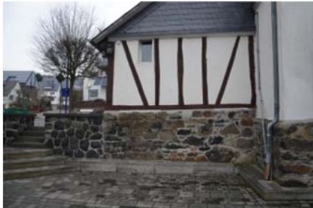
Natursteinsockel und Sparfachwerk am Backhaus in Nenderoth
